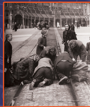
Houtblokjes uit trambaan Raadhuisstraat
